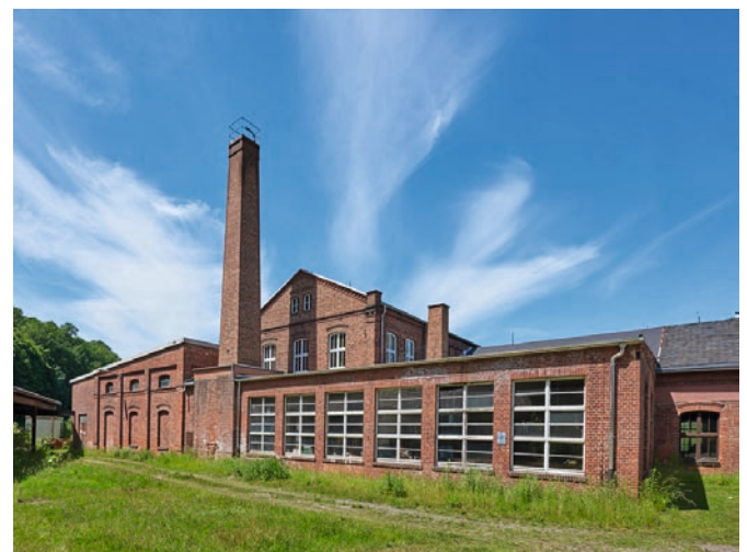
Wasserwerk Wiesenburg Quelle: Wasserwerke Zwickau GmbH – Foto-Atelier Lorenz
